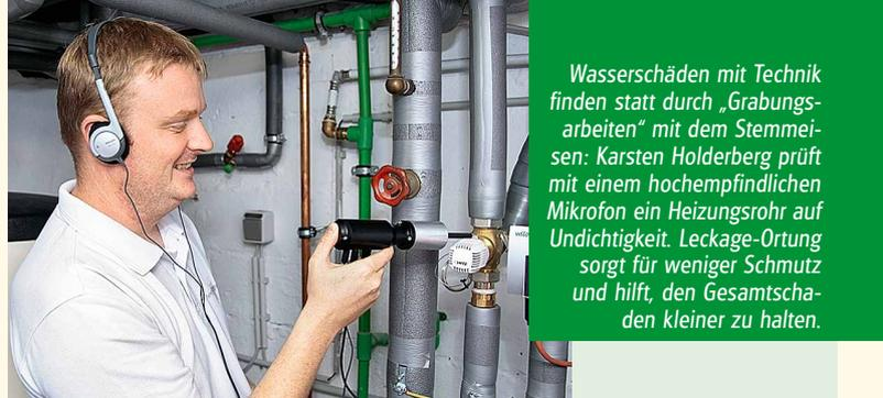
Wasserschäden mit Technik finden statt durch „Grabungsarbeiten“ mit dem Stemmeisen: Karsten Holderberg prüft mit einem hochempfindlichen Mikrofon ein Heizungsrohr auf Undichtigkeit. Leckage-Ortung sorgt für weniger Schmutz und hilft, den Gesamtschaden kleiner zu halten.
