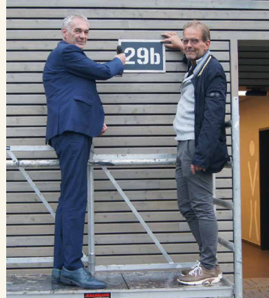
Der Bürgermeister persönlich bei letzten Mängelbeseitigungen? Nein, die Hausnummer wurde symbolisch in einem kleinen Festakt von Ralf Köpke (l.) und Jürgen Paulus vom ausführenden Bauunternehmen Hegerath angebracht.
