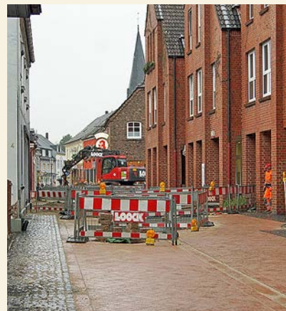
Neue Pflasterung auf der Hochstraße
